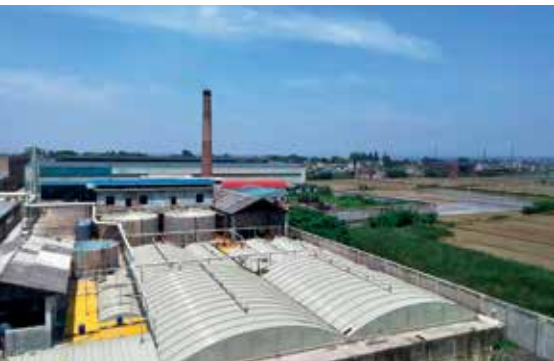
图2 生物滴滤池+光催化氧化除臭
