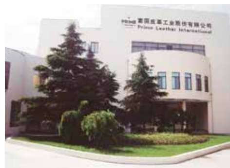
富国皮革工业股份有限公司新建办公楼
