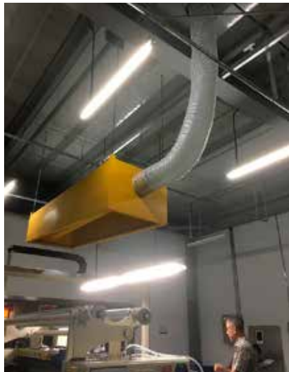
图 6 辊涂机集气罩
